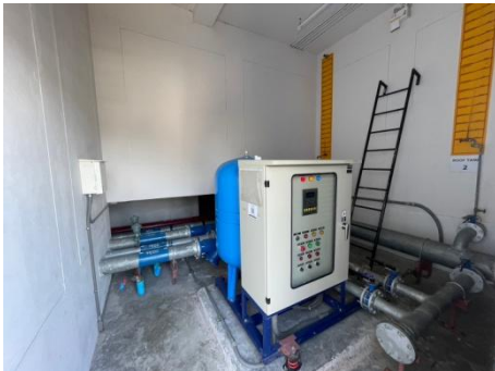
รูปที่ 2-22 เครื่องปัมน้ำขึ้นตาดฟ้า
