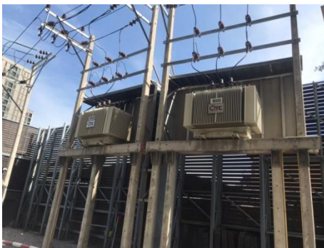
รูปที่ 2-20 หม้อแปลงไฟฟ้า
