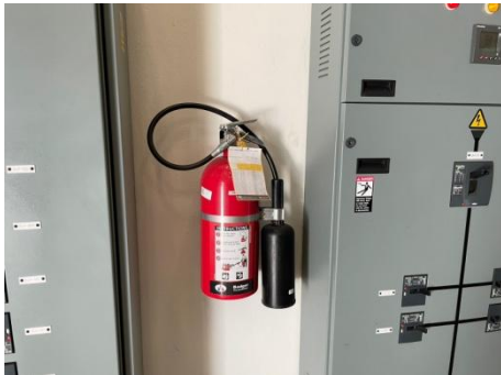
รูปที่ 2-8 ถังดับเพลิงชนิดมือถือพร้อมคำแนะนำการใช้งาน
