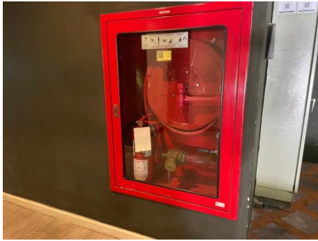
รูปที่ 2-4 ตู้เก็บสายฉีดน้ำดับเพลิง
