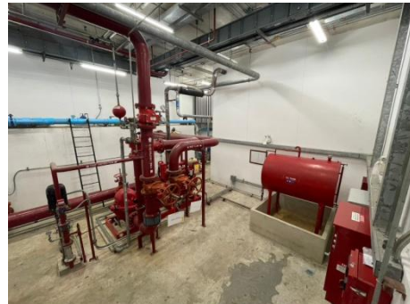
รูปที่ 2-23 เครื่องปัมน้ำดับเพลิง
