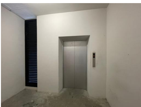
รูปที่ 2-16 ลิฟต์ดับเพลิง
