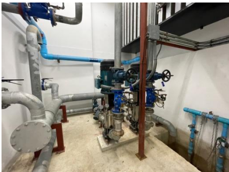
รูปที่ 2-24 เครื่องปัมน้ำขึ้นใต้ดิน
