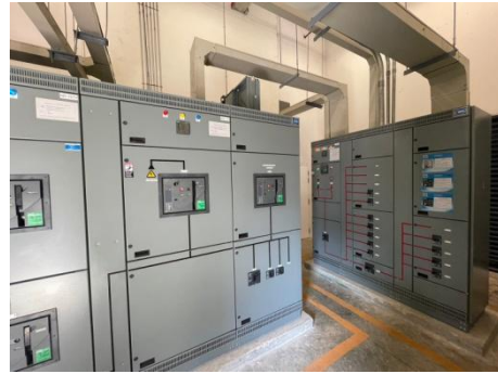
รูปที่ 2-19 ห้องแผงจ่ายไฟฟ้า (MDB)
