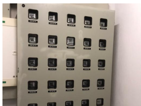
รูปที่ 2-17 มิเตอร์ไฟฟ้า
